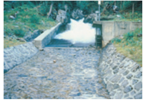
Tirolerwehr mit Restwasser (Bild H. Roth)
